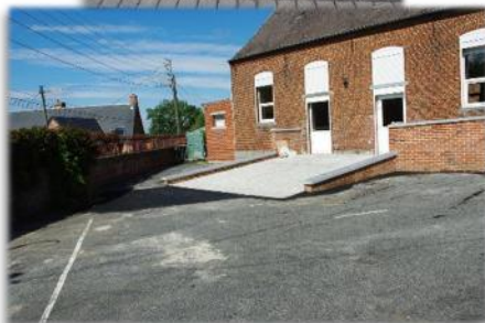
Terrassement pour réalisation des accès, pavage et petit muret en maçonnerie.
