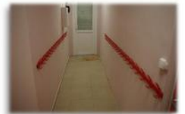
Coulage d'une dalle, pose du carrelage, peintures et aménagements pour le couloir.
