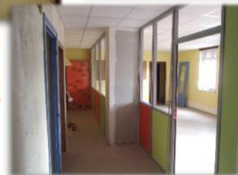
Elargissement des portes pour l'accessibilité, coulage de la dalle, puis carrelage, peinture et cloisons.
